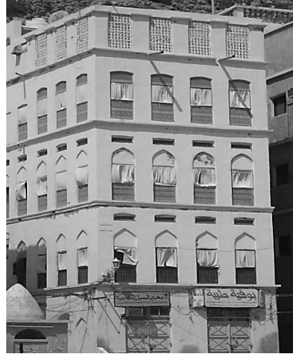
واجهة مبنى تقليدي يبين المناور أعلى النوافذ (تصوير الباحث)
