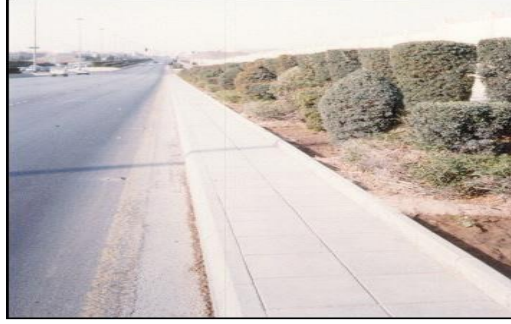
شكل ١ يوضح الطريقة الصحيحة لزراعة الأرصفة وذلك بزراعة النباتات على جانب الرصيف وترك مساحة عريضة من الرصيف لمرور المشاة
